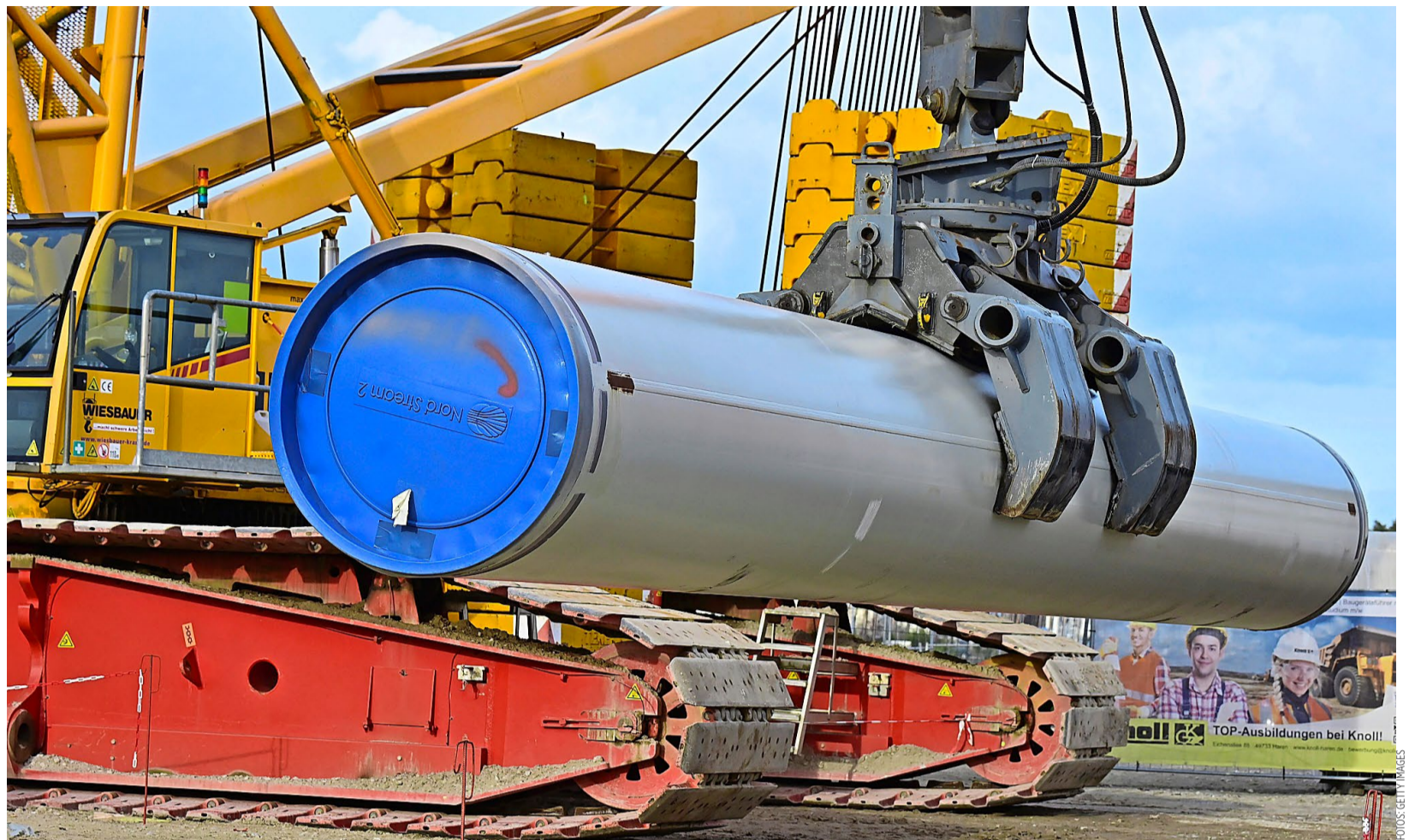
Röhren für Europa: Der Bau der Ostsee-Pipeline Nord Stream 2 ist mittlerweile abgeschlossen. Doch wann fliesst das Gas aus Russland?
